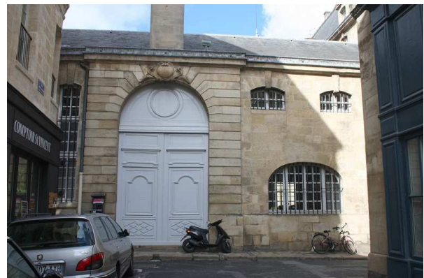
Aile sud de l'hôtel des Douanes sur la rue Émile-Duployé.
