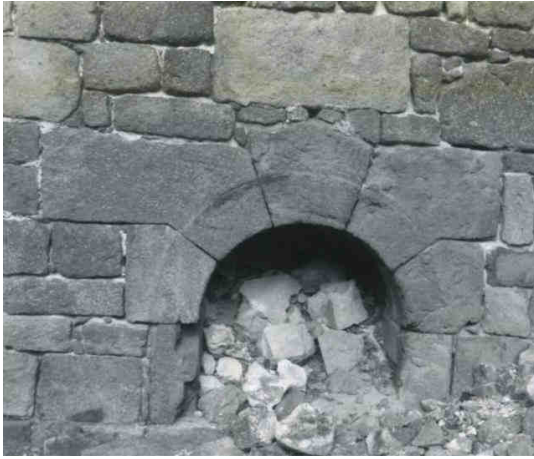
Les claveaux d'un des foyers à Terre-de-Bas (P 3)
