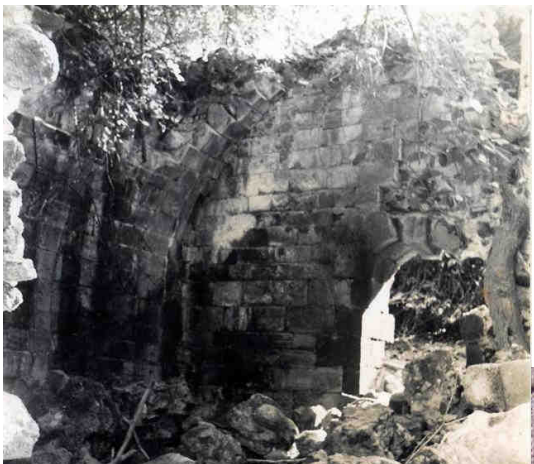
Les briques réfractaires intérieures et la porte de chargement à l'arrière (P 3)
