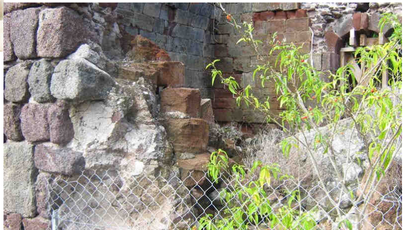
Les briques réfractaires intérieures et la porte de chargement à l'arrière (P 3)
